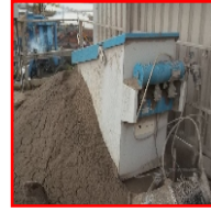
OVERVULLEN VAN DE SILO
