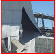
SCHEUREN VAN DE SILO
