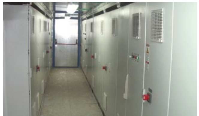
Armoires de puissance à l'intérieur du Powertainer
