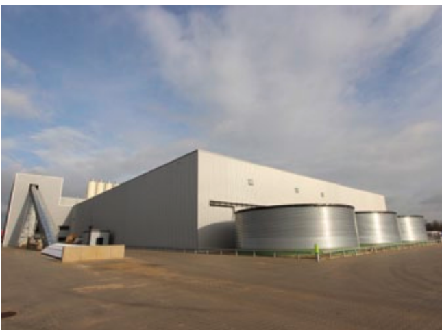
Vue extérieure d'une usine de fabrication des blocs en béton
